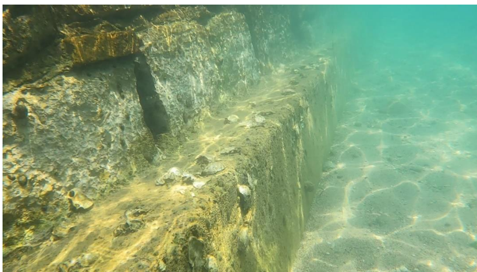
Slika 4. Nožica postojećeg obalnog zida sa izvršenom sanacijom betonskom plombom
